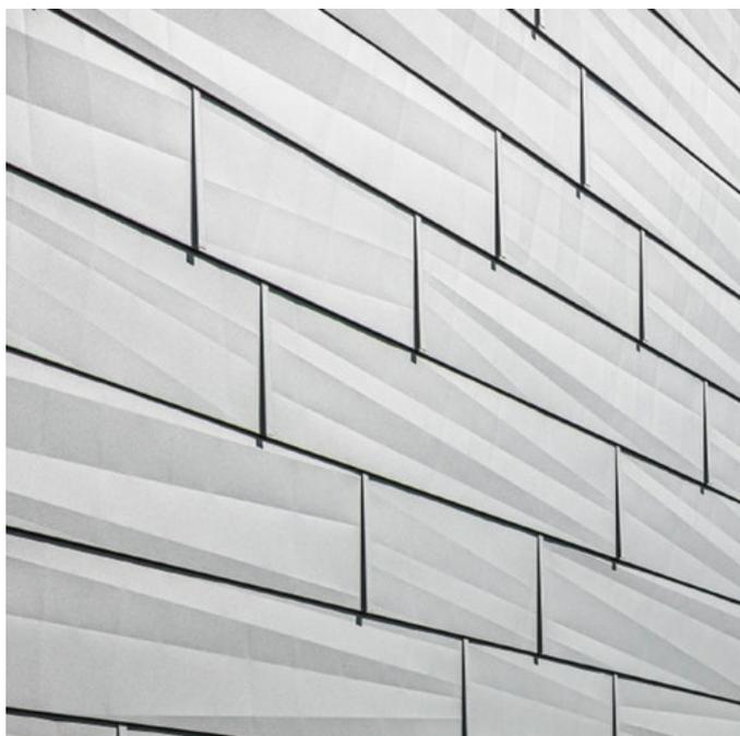
Фасадная панель FX.12 с характерными кромками, P.10 светло-серая
