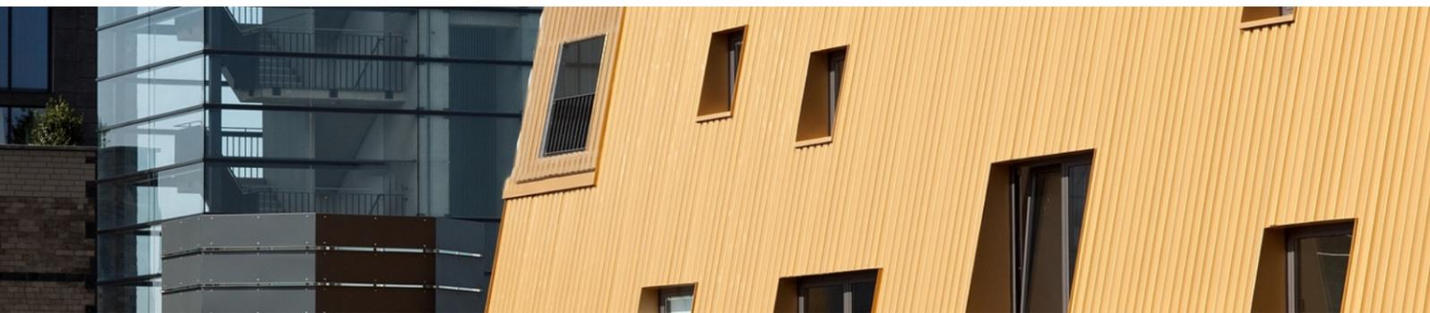
Благодаря своей четкой структуре трапецевидные панели не только подчеркивают технический характер металла, образуя в результате поверхности также отражают квадратные и прямоугольные основные формы архитектуры. Трапецевидные профили ALUFORM предлагают достаточно гибкие решения для вашего видения. Стандартные размеры трапецевидных профилей: 20/125, 29/124, 30/153, 40/167, 42/250, 45/150, 45/200. Ниже представлен чертёж типа 29/124 типа А.
